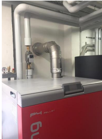
Abbildung 3: Holzhackschnitzel-Heizung (Foto: https://www.beeskow.de/seite/230703/leuchtturmprojekt.html )
